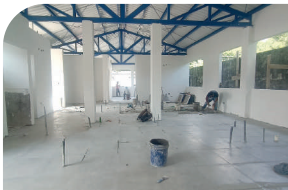
Construcción Edificio Dirección Departamental de Retalhuleu.
