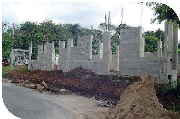
Construcción Edificio Dirección Departamental de Retalhuleu.
