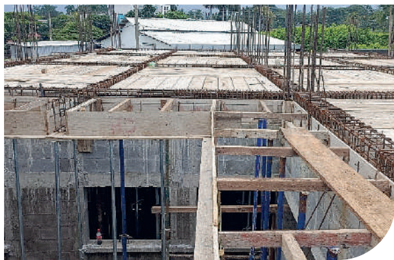
Ampliación Hospital de Retalhuleu, área de Emergencia.
