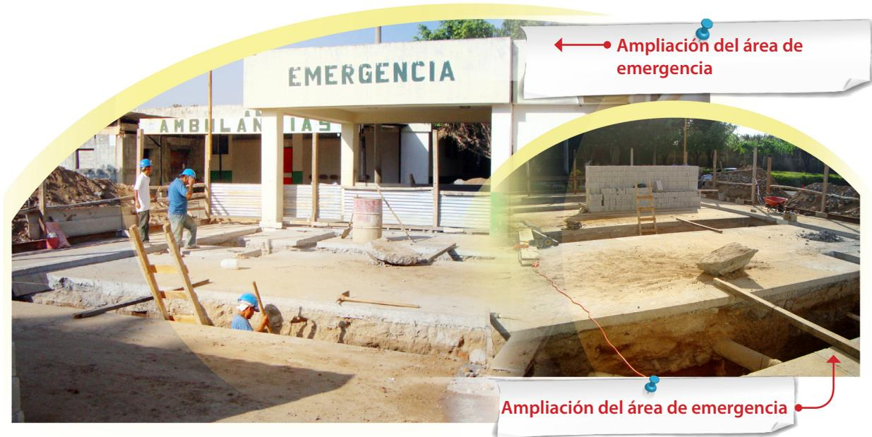
El proyecto de ampliación, con un área total de 688.13m<sup>2</sup> de construcción, con muros de mampostería, losa de concreto y piso de porcelanato. Ubicado en el Hospital del IGSS de Retalhuleu entre 8ª calle y Boulevard Centenario Zona 3 de Retalhuleu, el costo aproximado del proyecto es de Q3,380,730.00.
