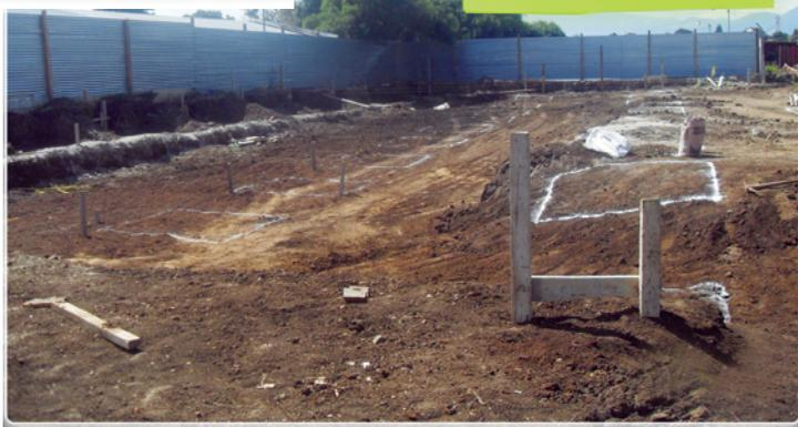
Avance de construcción: se encuentra en fase de trazo y estaqueado para continuar con la excavación y poder realizar el armado y fundición de la cimentación.
